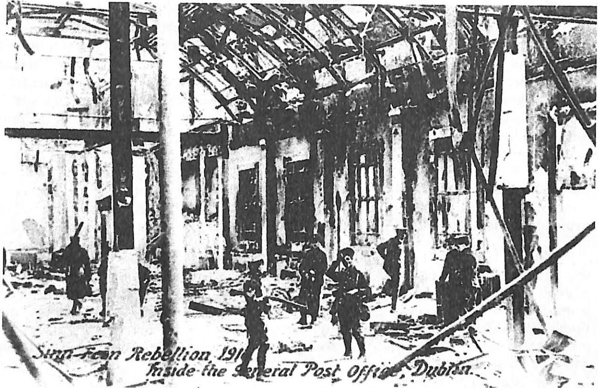
La grande poste de Dublin après l'écrasement de l'insurrection
