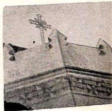
← Croix surmontant le minaret de l'ancienne mosquée de Bab Djédid.
